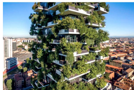
ビルの壁面を緑化
